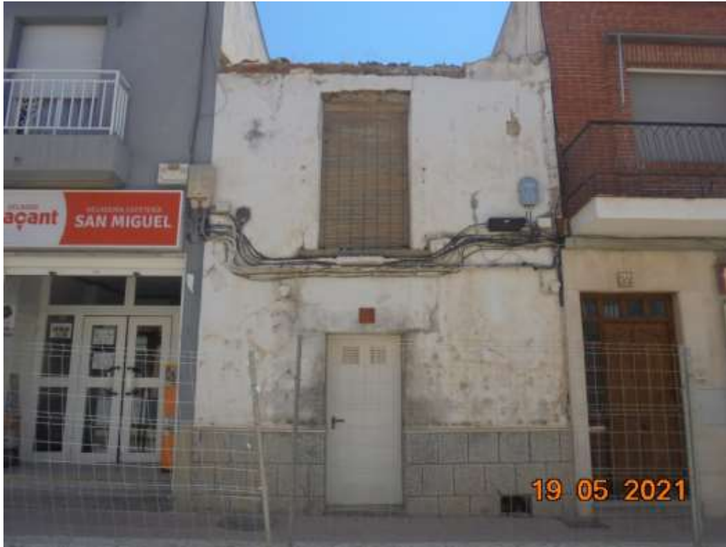
FOTOGRAFÍA DE LA FACHADA A LA AVENIDA DE ANDALUCÍA DE LA FINCA REGISTRAL 1724
